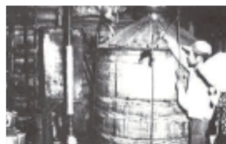
▲田中式蒸溜釜を使い取卸油作業風景
